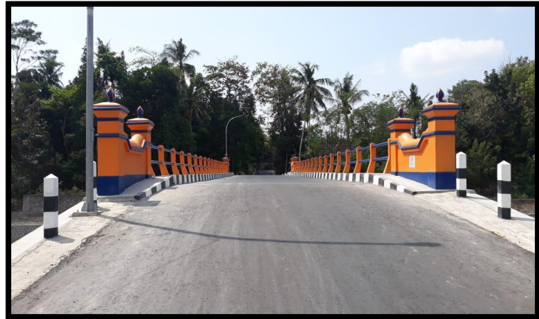
Gambar 3. 4 Pembangunan Konstruksi Jembatan Dzikrul Ghofilin
