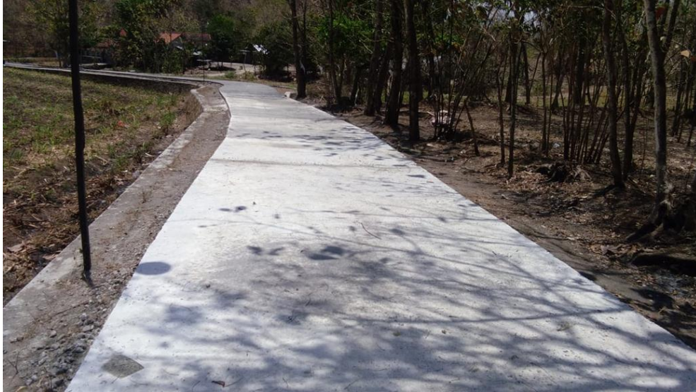
Gambar 4. 1 Pengerasan Jalan Desa Bawuran
