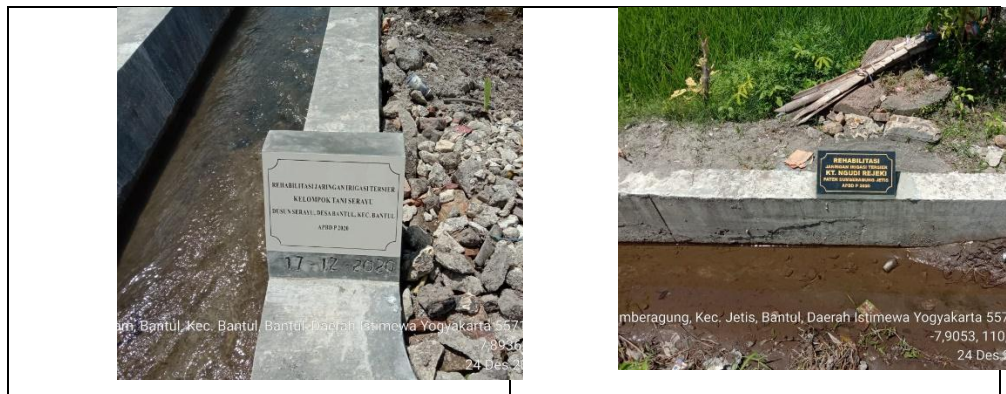
Gambar 3. 12 Rehabilitasi Jaringan Irigasi Tersier Dusun Serayu dan Desa Sumberagung
