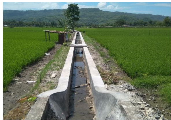
Foto 100% Rehabilitasi Jaringan Irigasi DI Tegal
