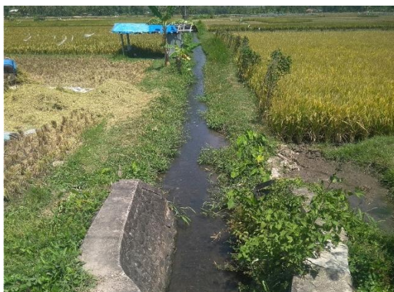
Foto 0% Rehabilitasi Jaringan Irigasi DI Tegal
