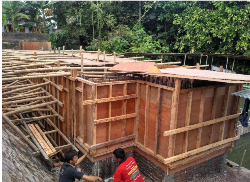
Gambar 3. 1 Pembangunan IPAL Komunal di Kal. Tamanan
