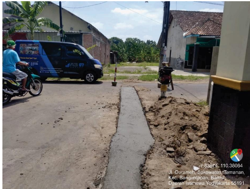
Gambar 3. 18 Pembangunan SR SPAM Jaringan Perpipaan di Bawuran
