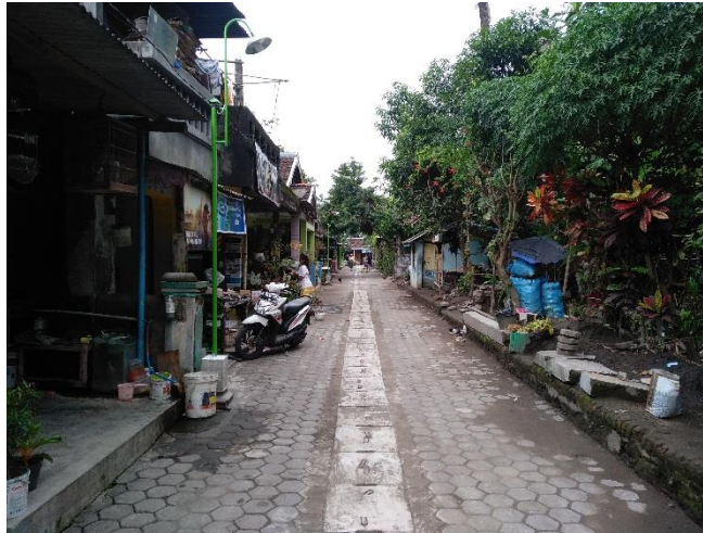
Gambar 3. 21 Pembangunan Drainase Lingkungan di Kepek Timbulharjo Sewon
