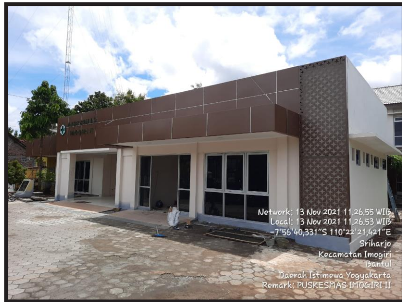
Sumber: Dinas Kesehatan Kab. Bantul, 2021 Gambar 3. 4 Puskesmas Imogiri II setelah di rehab
