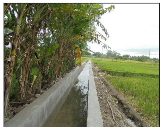
Gambar 3. 16 Angkat sedimen dan pembersihan rumput dan tanaman liar pada saluran irigasi Daerah Irigasi Dokaran
