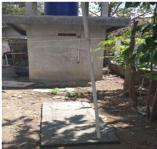
Gambar 3. 19 Pembangunan Tangki Septik Individu di Paten, Sumberagung, Jetis an SUMILAH
