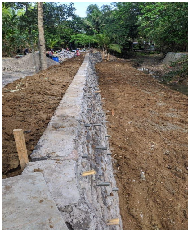
Gambar 3. 13 Pembangunan Perkuatan Tebing Sungai Celeng di Kapanewon Imogiri
