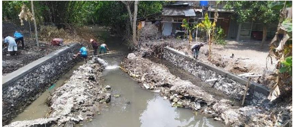
Gambar 3. 12 Proses pembangunan Afvour Karangmojo di Kapanewon Bantul
