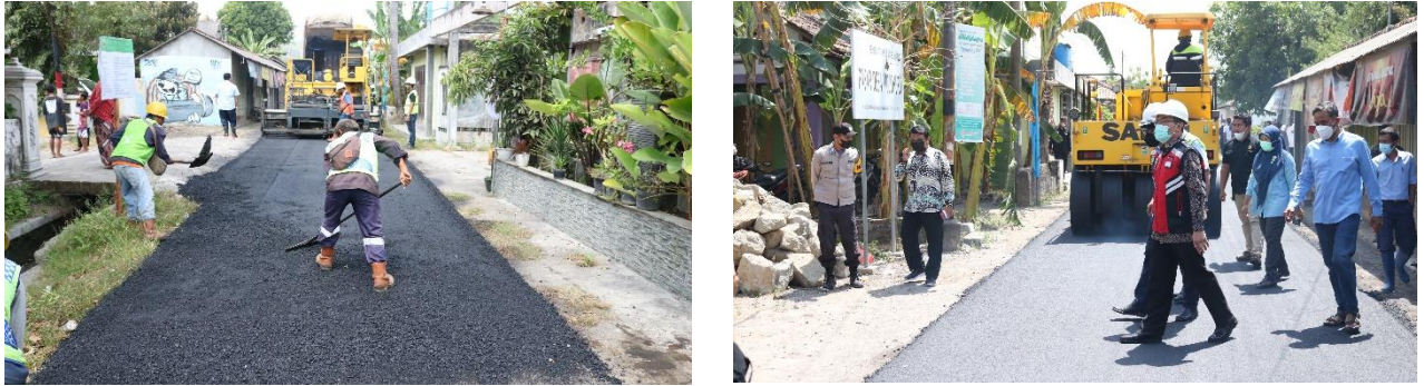
Gambar 3. 22 Kegiatan Peningkatan Ruas Jalan Mojohuro – Demi di Kapanewon Imogiri
