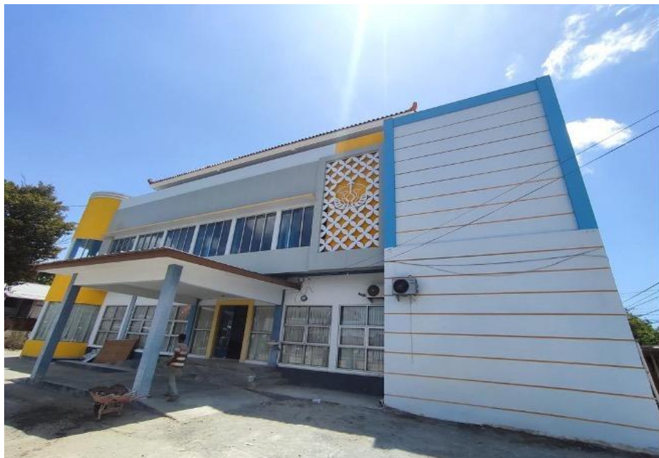
Gambar 2.3.16 Pembangunan Gedung Metrologi
