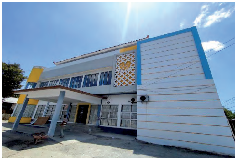
Gambar 3.2 Pembangunan Gedung Metrologi
