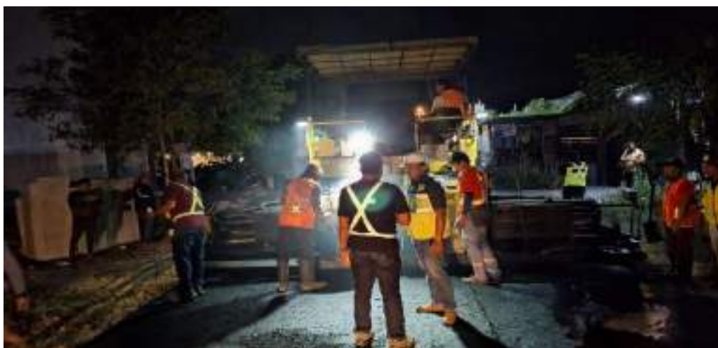
Gambar 2.6 Dokumentasi Hasil Kegiatan Pengaspalan Jalan (Sumber: DPUPKP Kab. Bantul, 2025)
